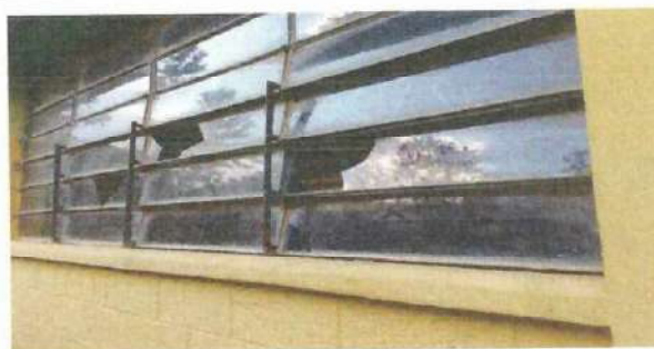
FOTO 2: Sustitución de balcones
