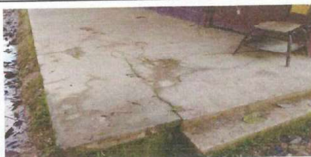
FOTO 6: Sustitución de torta de cemento
