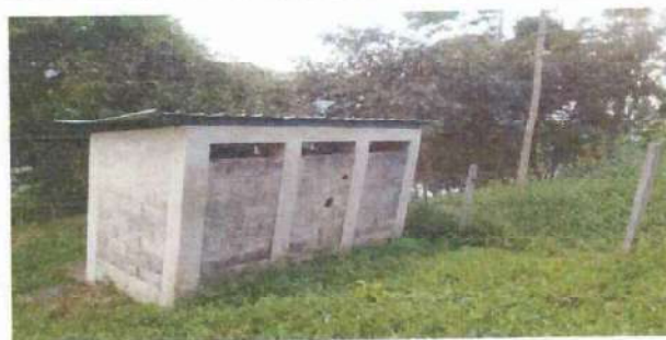
FOTO 4. Sustitución de acabado de pared de baño
