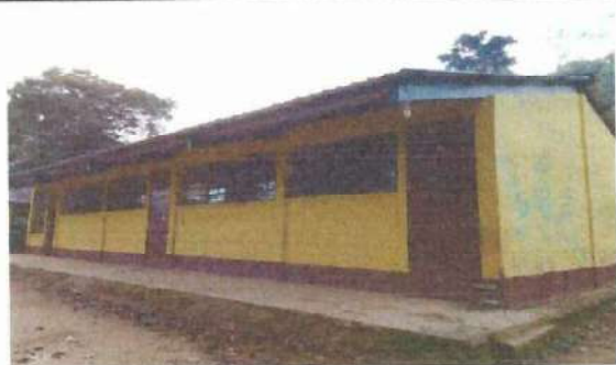
FOTO 1: Sustitución de laminas troqueladas y estructura metálica.
